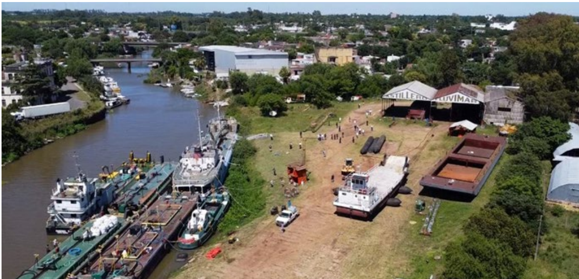
Imagen 4 - Predio actual Astillero. Frente sobre el Arroyo Saladillo.
