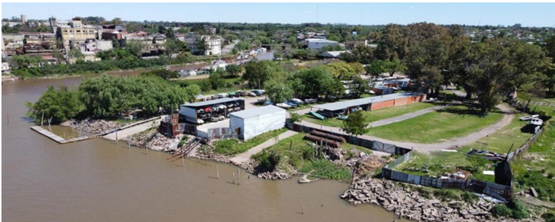
Imagen 6 - Predio de la ex Guardería Puerto Náutico Rosario. Vista sobre el río Paraná.
