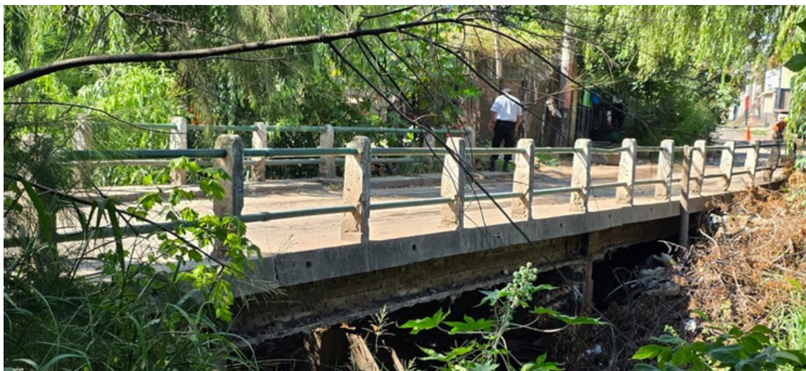
Imagen 14 - Puente de acceso a la zona del Mangrullo.
