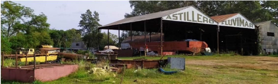
Imagen 3 - Predio actual Astillero. Galpones existentes.
